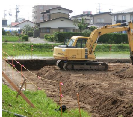
造成工事中の建設予定地 6月3日
